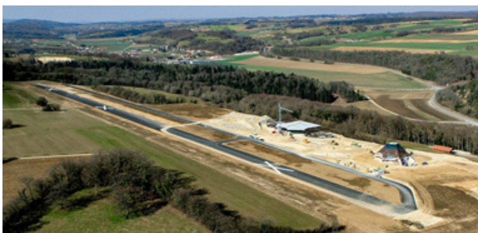
Am 9. März 2011 präsentierte sich der neue Flugplatz Bressaucourt im Endausbau. Vier Monate später erfolgte die Eröffnung. Foto Aerojura
